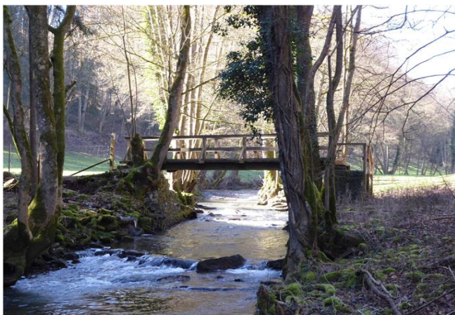
Foto gegen Fließrichtung
