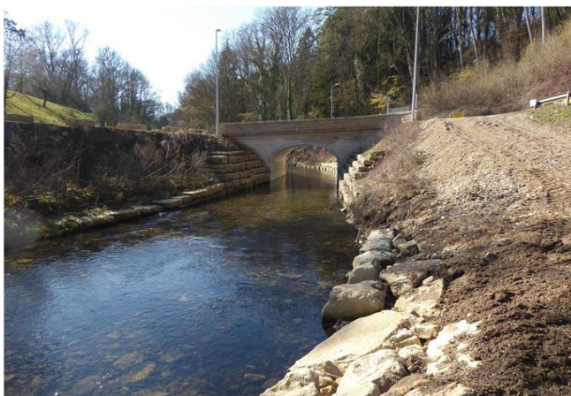
Foto gegen Fließrichtung
