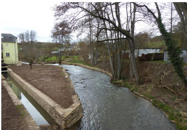
Foto gegen Fließrichtung
