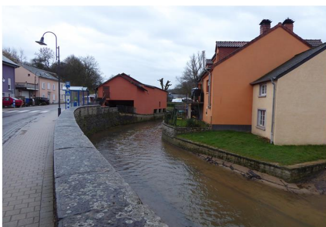
Foto gegen Fließrichtung
