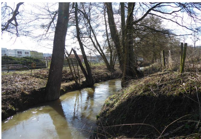
Foto gegen Fließrichtung
