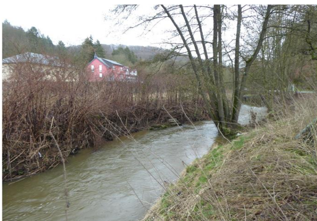
Foto gegen Fließrichtung
