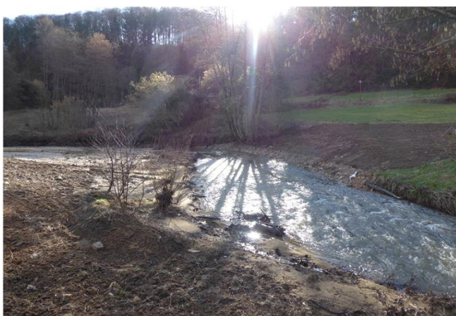
Foto gegen Fließrichtung
