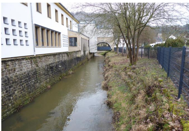
Foto gegen Fließrichtung
