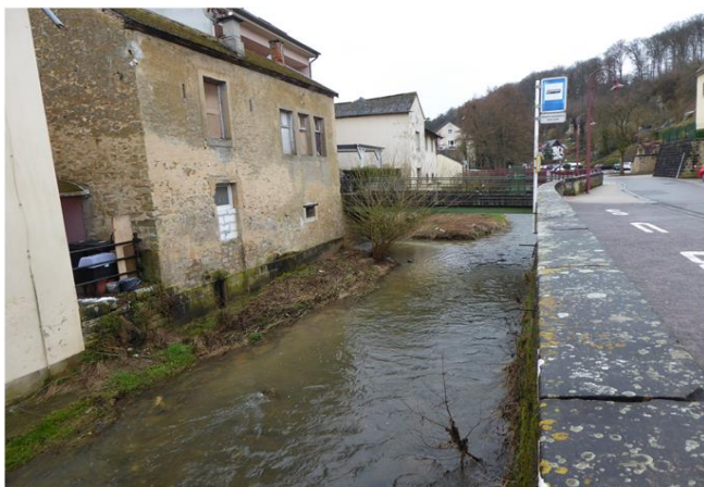
Foto gegen Fließrichtung
