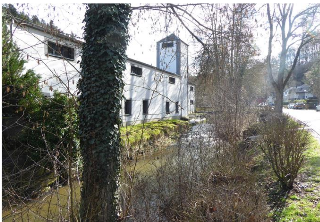
Foto gegen Fließrichtung
