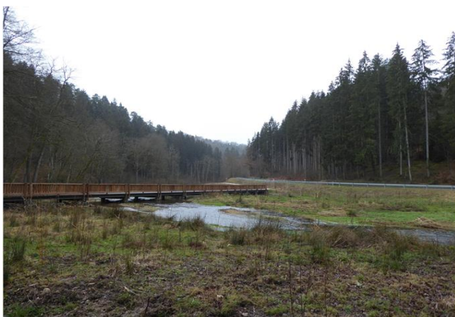
Foto gegen Fließrichtung
