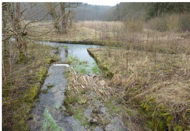
Foto gegen Fließrichtung
