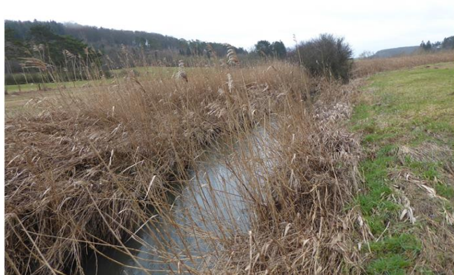
Foto gegen Fließrichtung
