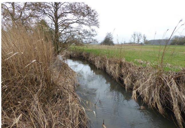
Foto gegen Fließrichtung
