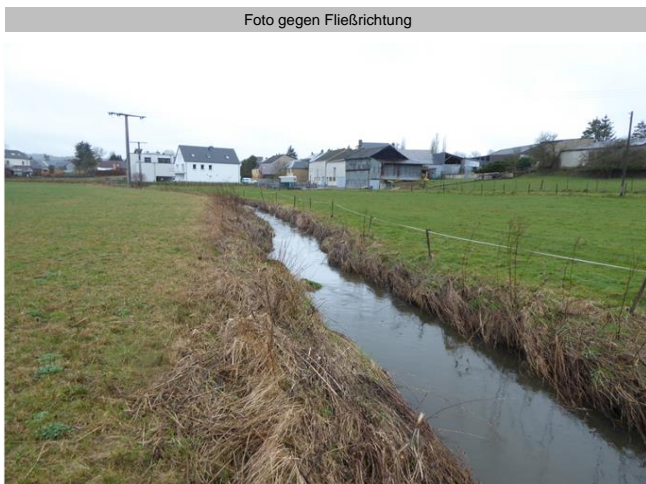
Foto gegen Fließrichtung
