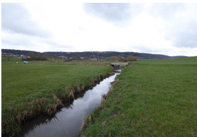
Foto gegen Fließrichtung
