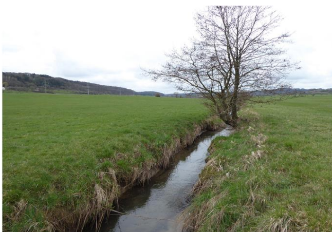
Foto gegen Fließrichtung
