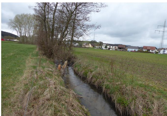
Foto gegen Fließrichtung
