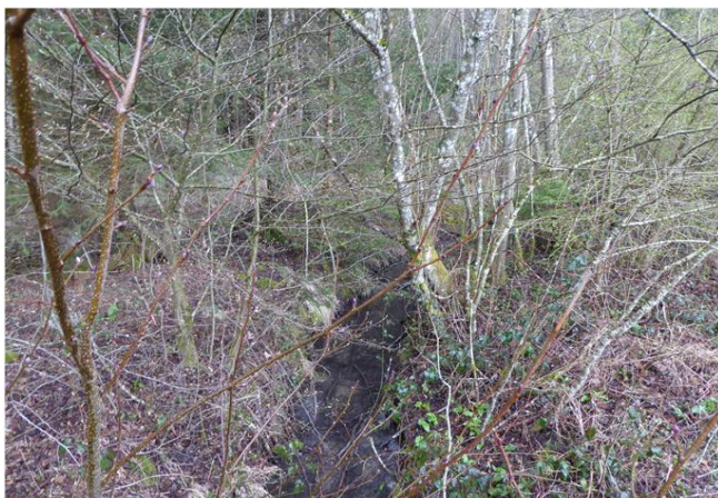
Foto gegen Fließrichtung
