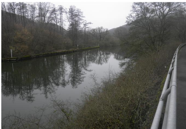
Foto gegen Fließrichtung
