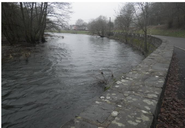
Foto gegen Fließrichtung
