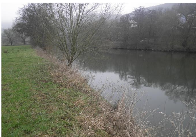
Foto gegen Fließrichtung
