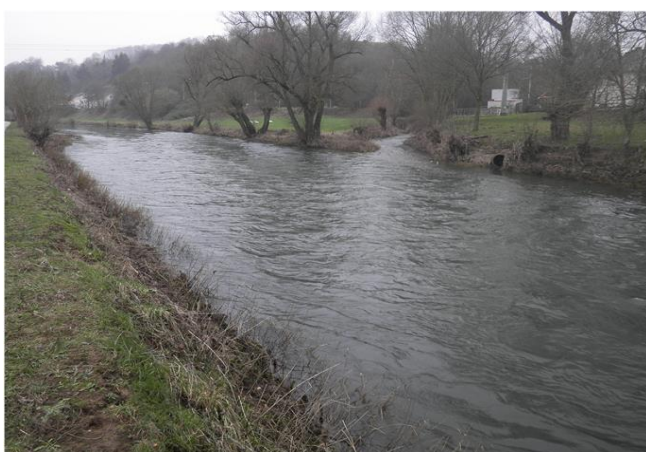
Foto gegen Fließrichtung
