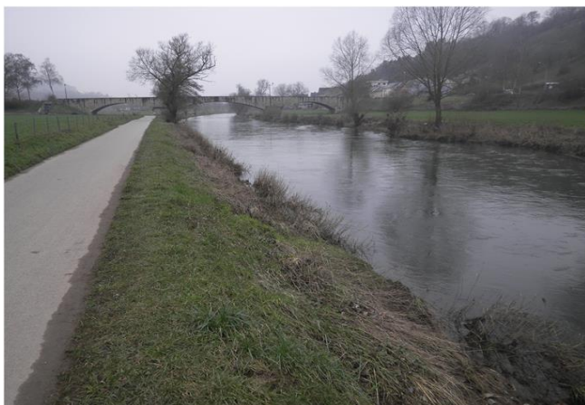
Foto gegen Fließrichtung
