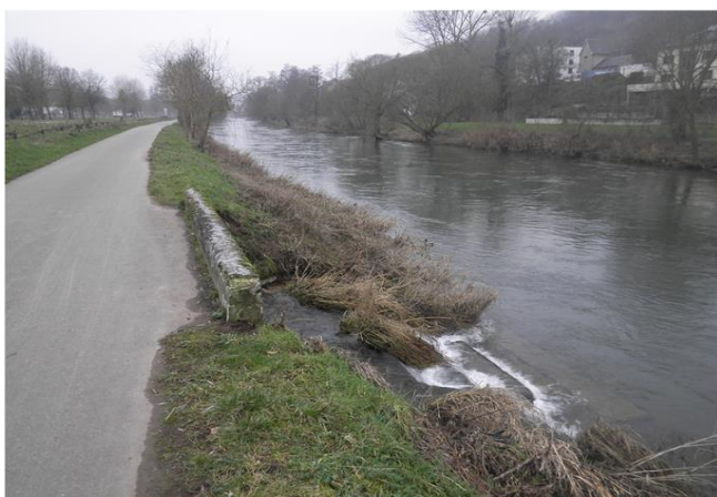
Foto gegen Fließrichtung
