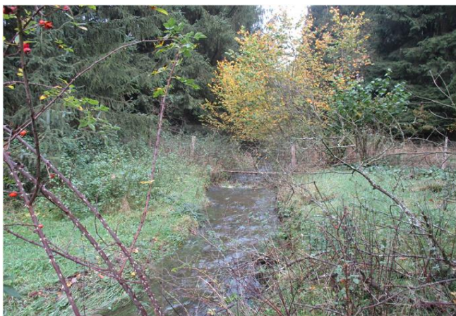
Foto gegen Fließrichtung
