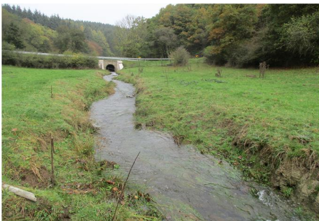
Foto gegen Fließrichtung
