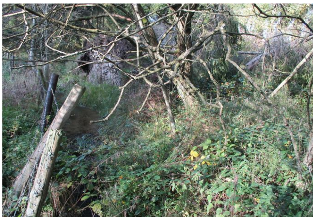
Foto gegen Fließrichtung
