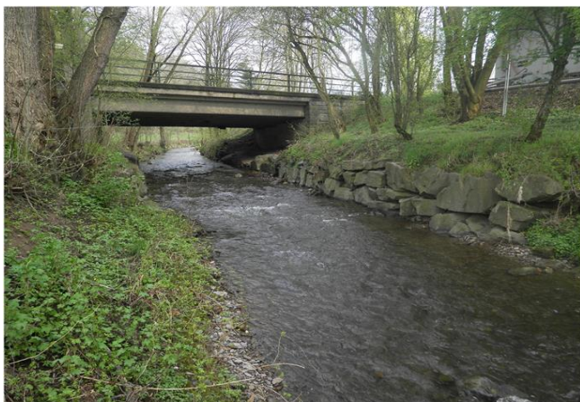
Foto gegen Fließrichtung
