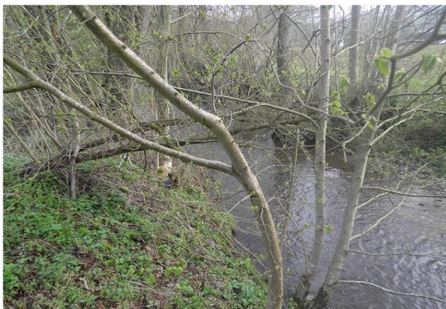
Foto gegen Fließrichtung
