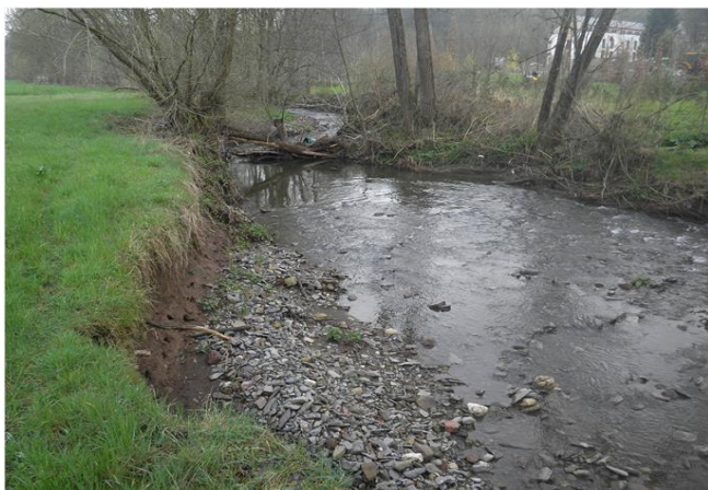
Foto gegen Fließrichtung
