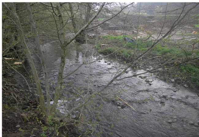
Foto gegen Fließrichtung
