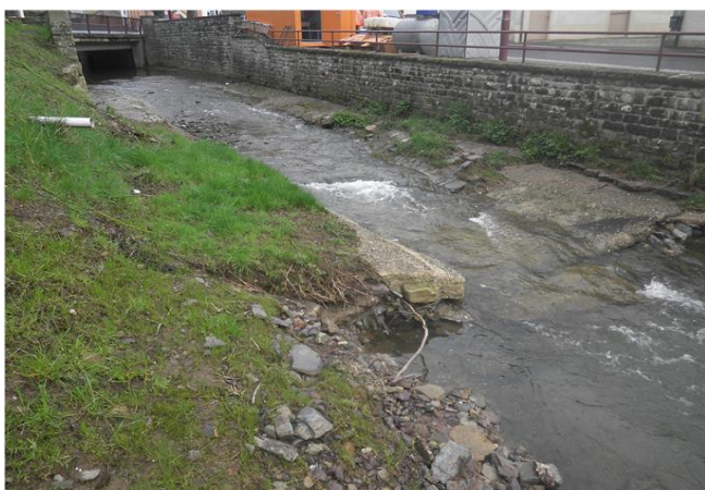
Foto gegen Fließrichtung
