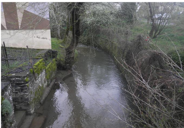
Foto gegen Fließrichtung
