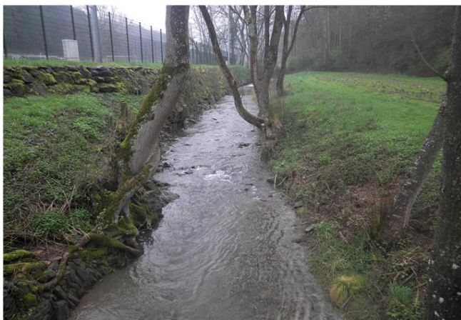
Foto gegen Fließrichtung
