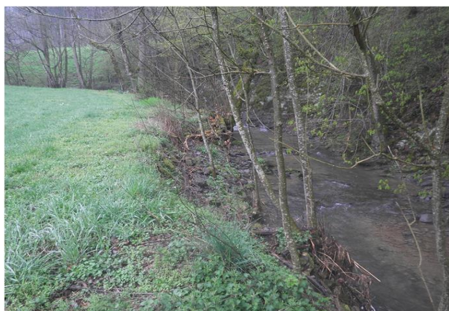
Foto gegen Fließrichtung
