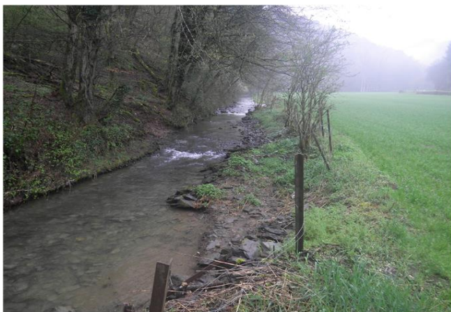
Foto gegen Fließrichtung
