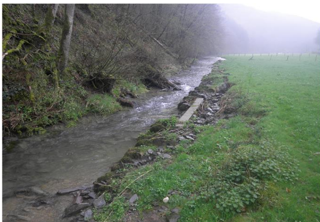
Foto gegen Fließrichtung
