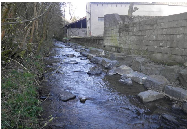
Foto gegen Fließrichtung
