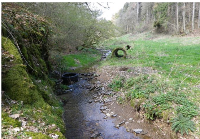
Foto gegen Fließrichtung
