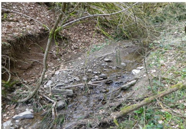
Foto gegen Fließrichtung
