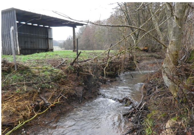
Foto gegen Fließrichtung
