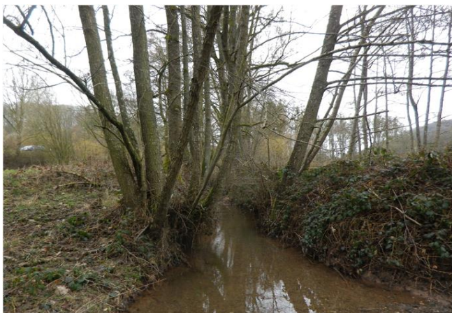
Foto gegen Fließrichtung
