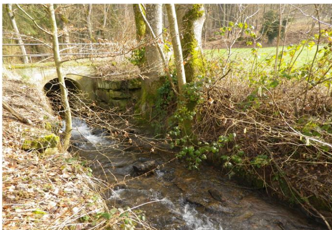
Foto gegen Fließrichtung
