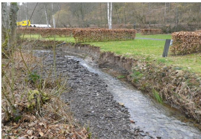
Foto gegen Fließrichtung
