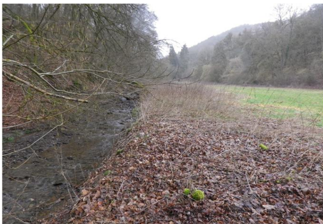
Foto gegen Fließrichtung
