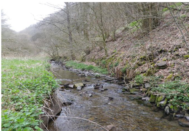
Foto gegen Fließrichtung
