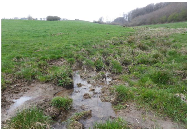
Foto gegen Fließrichtung
