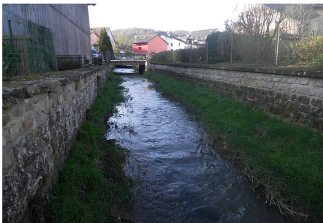
Foto gegen Fließrichtung
