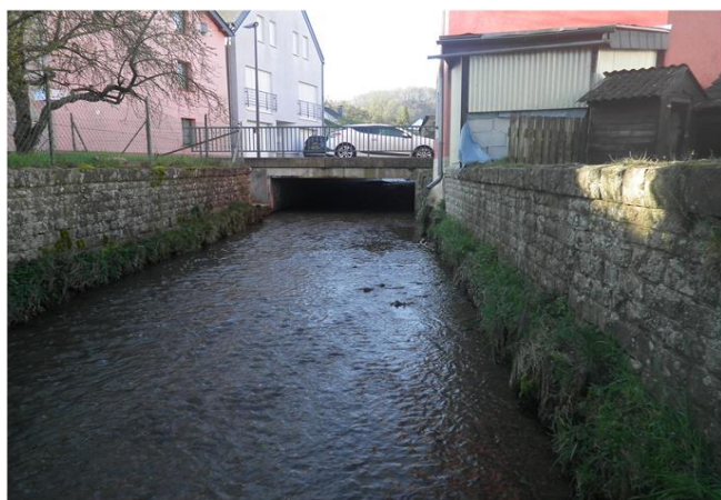
Foto gegen Fließrichtung
